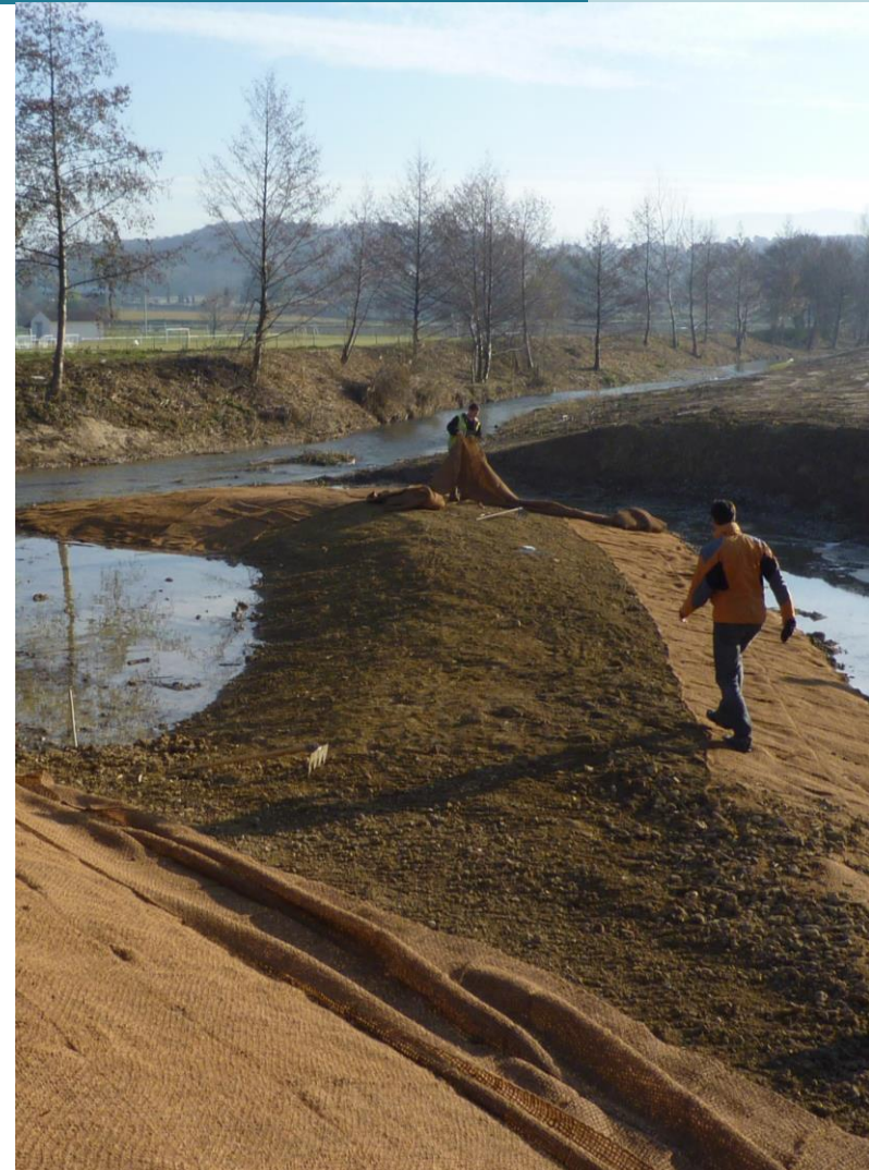
Exemple de travaux de restauration de cours d'eau
