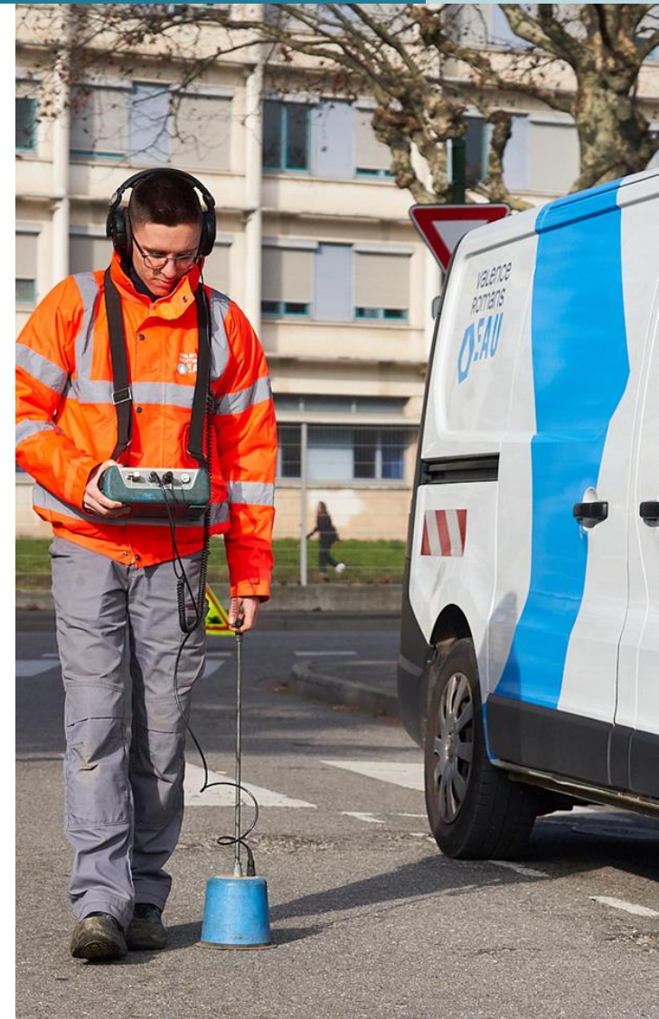
Opération de recherche de fuite
